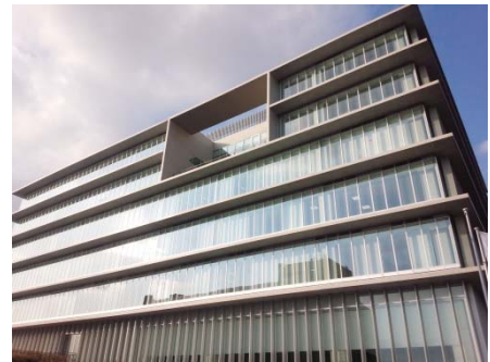
底による外壁汚れの軽減（紀の川市）
