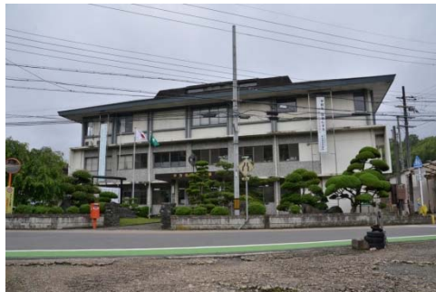
(役場庁舎) 平成17年度に実施された耐震診断では各棟とも耐震補強が必要との結果である。S34年建築
