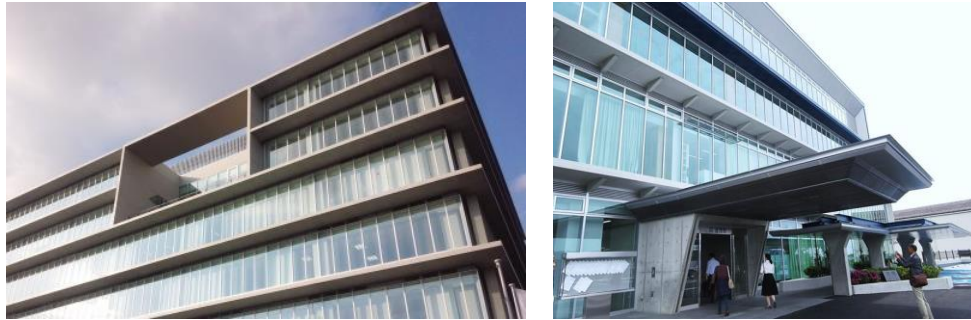
庇による外壁汚れ等の軽減
