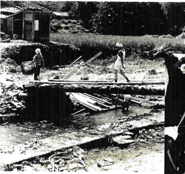
仮設橋による復旧作業
