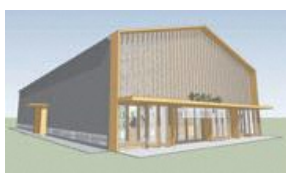
平成30年3月竣工予定
