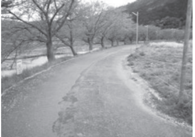
（左）立川区郷之口湯屋谷線の道路側溝改良（下）荒木区3の18号線の舗装修繕
