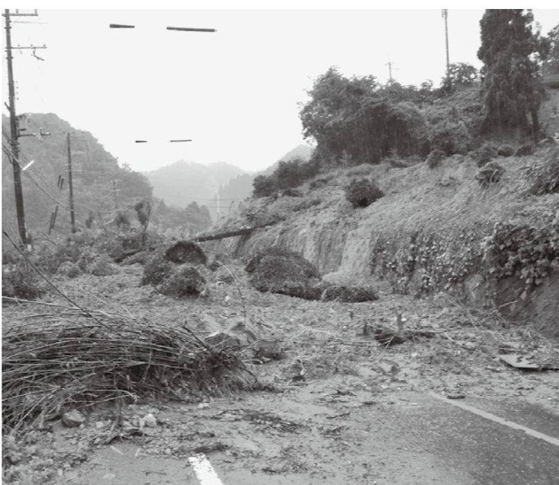
↑ 昨年の台風18号により土砂が流出した国道307号 (奥山田)
