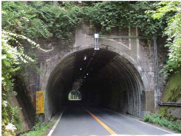
写真2. 1 奥山田隧道起点側坑口
