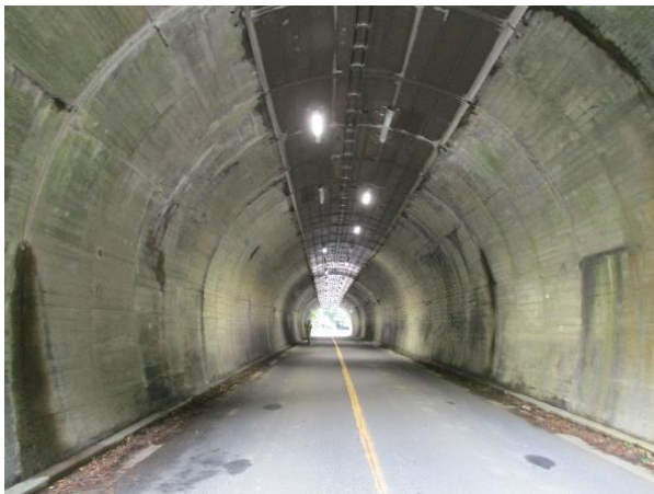
写真2. 3 奥山田隧道 内部状況
