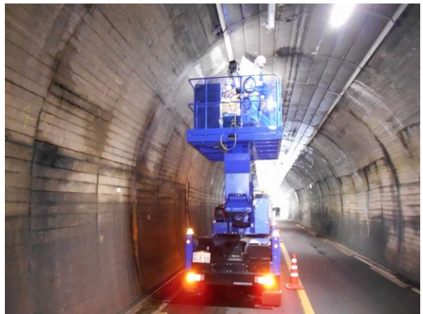
写真2. 4 奥山田隧道 点検状況
