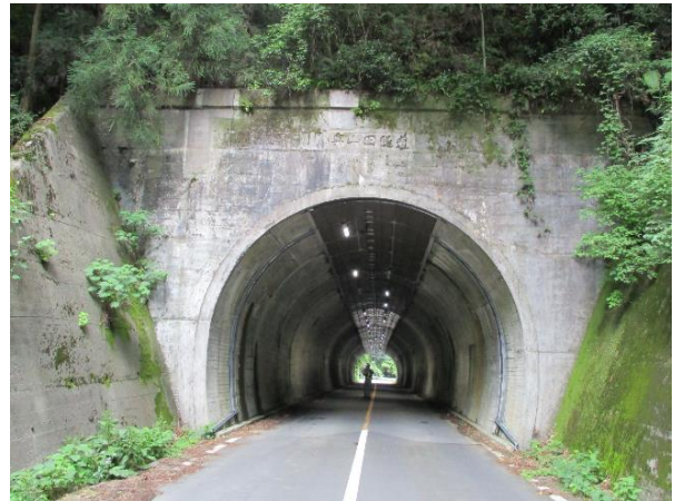
写真2. 2 奥山田隧道終点側坑口
