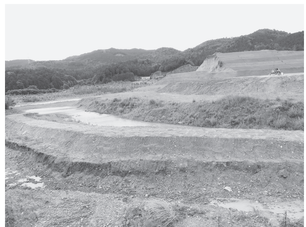
整備中の新市街地
