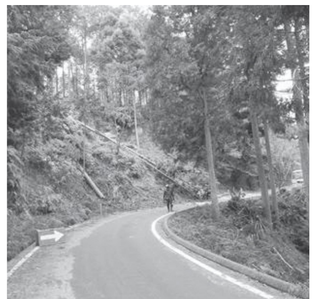
のり面改良工事が行われている林道大峰線
