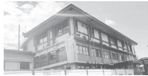
解体される旧庁舎
