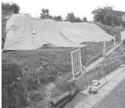
岩山地区長山の土砂崩落現場
