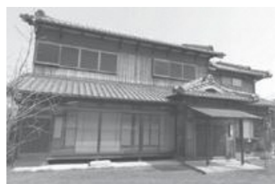
南地区にあるお試し住宅
