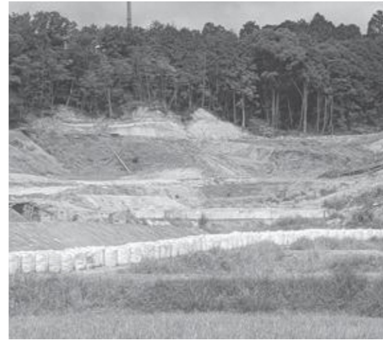
岩山小釜、サンビレッジ付近の盛土
