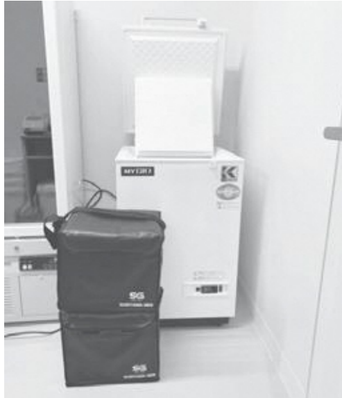
ワクチン用冷蔵庫が設置される
