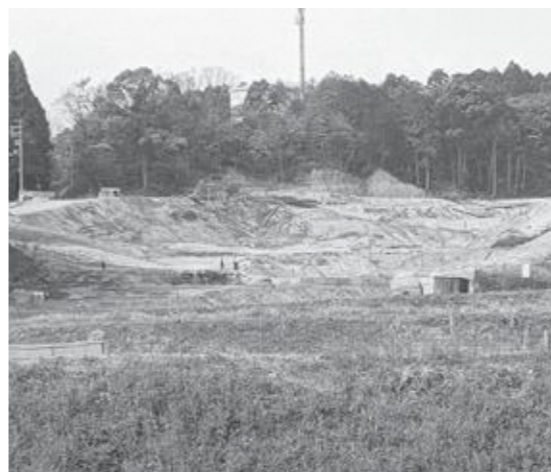
岩山小釜の伐採現場
