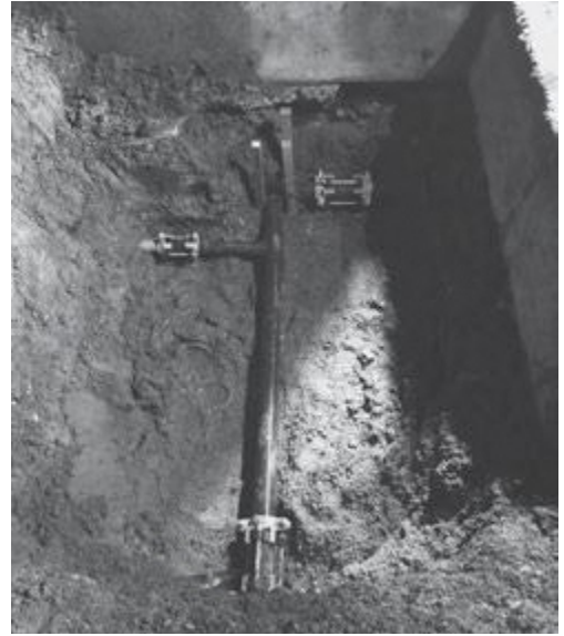
老朽化により更新した水道管
