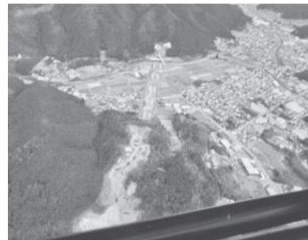
上空から見た「うじたわら」新名神の橋脚が続く（郷之口付近）
