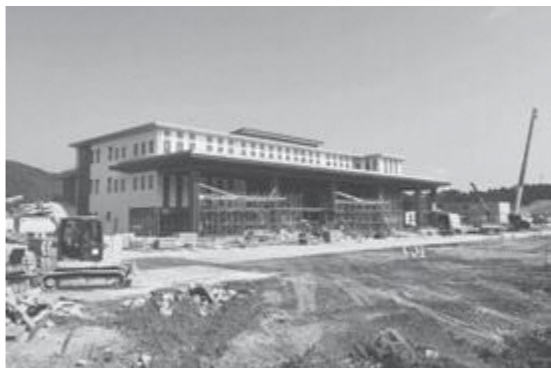
建設中の新庁舎
