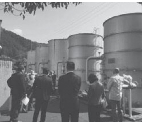
浄水場のろ過装置を確認
