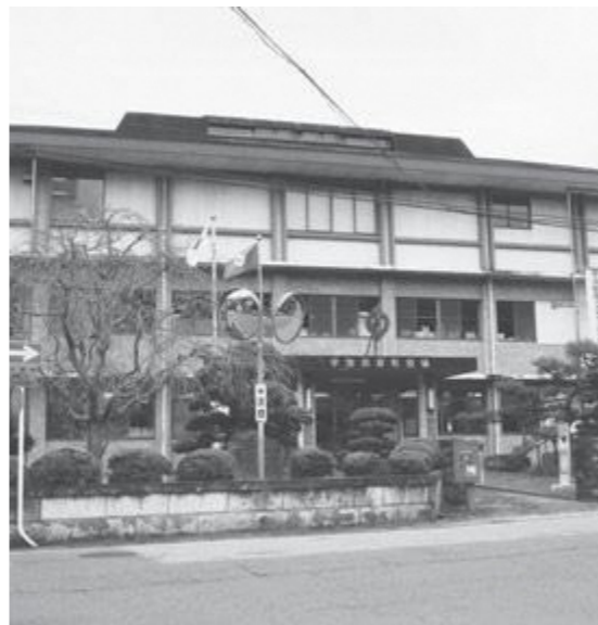
売却予定の現庁舎
