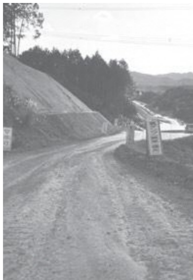
工事が進む山手線
