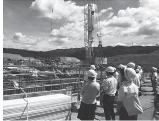
建設が進む新庁舎
