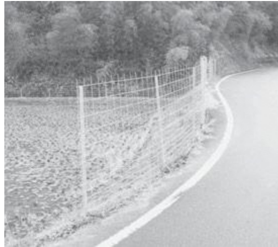
フェンスで囲まれた圃場(京田辺市)
