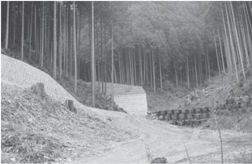
中谷地域堰堤工事
