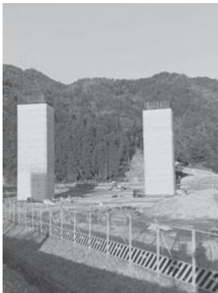
新名神高速道路工事 郷之口付近
