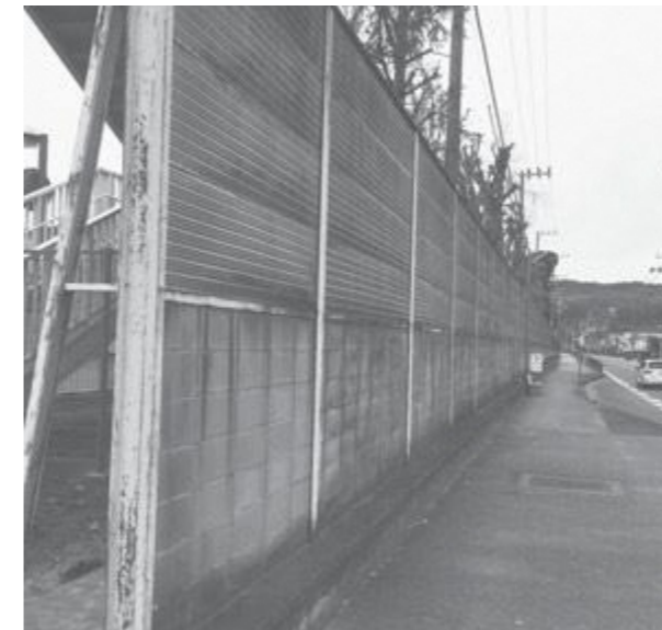
改修される田原小学校ブロック塀
