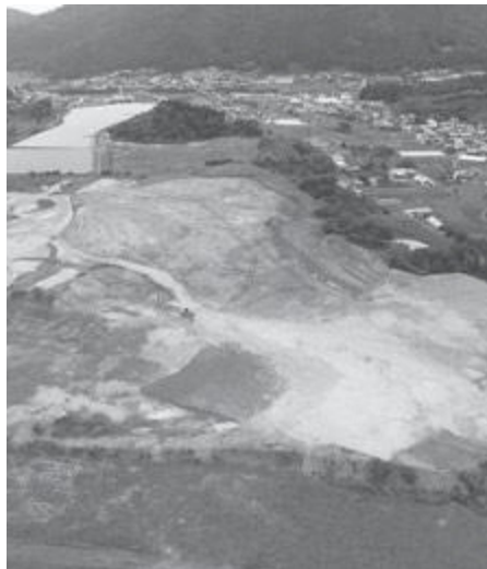
大規模盛土造成地は危険では
