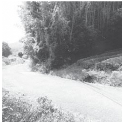
通峰線 接続部
