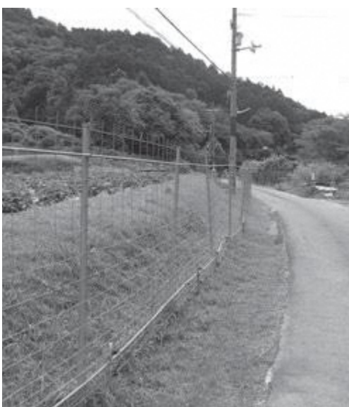
宇治市における金網設置状況
