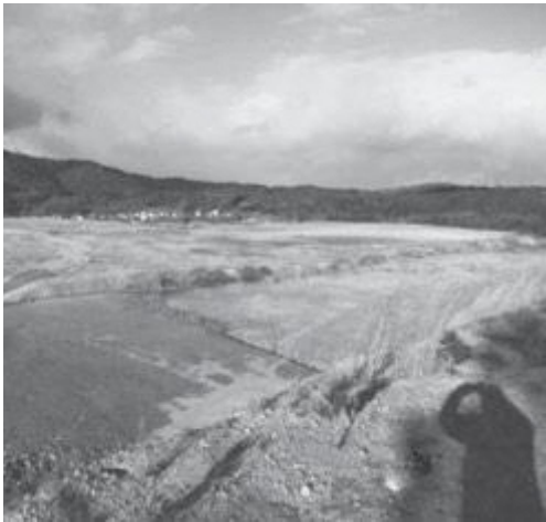
整備が進む新庁舎予定地
