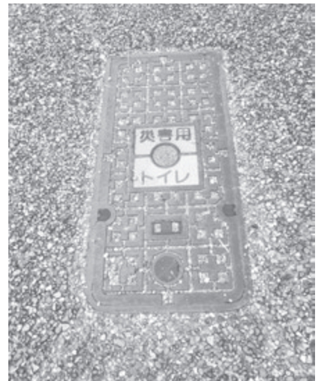
防災公園に設置されたマンホールトイレ(京田辺市)
