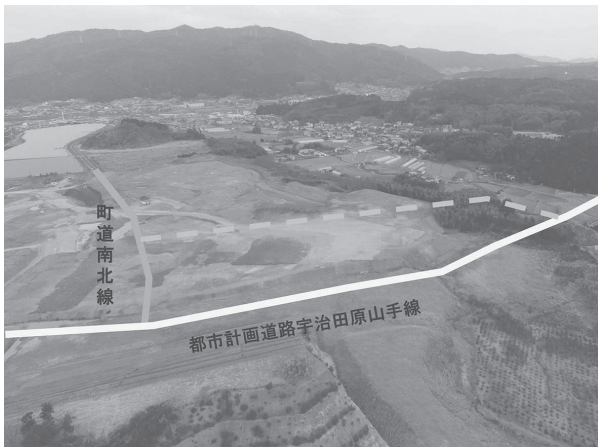
新庁舎建設予定地
