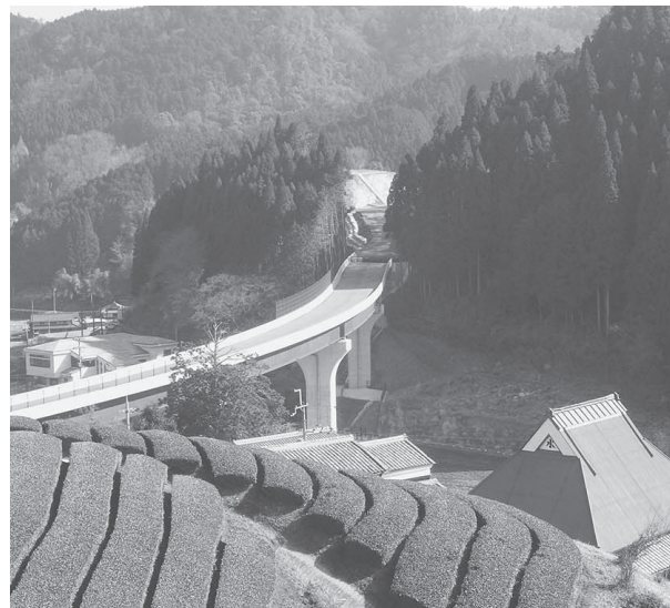
早期完成が望まれる奥山田バイパス
