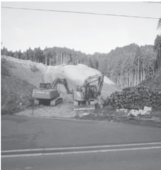
盛土工事現場付近
