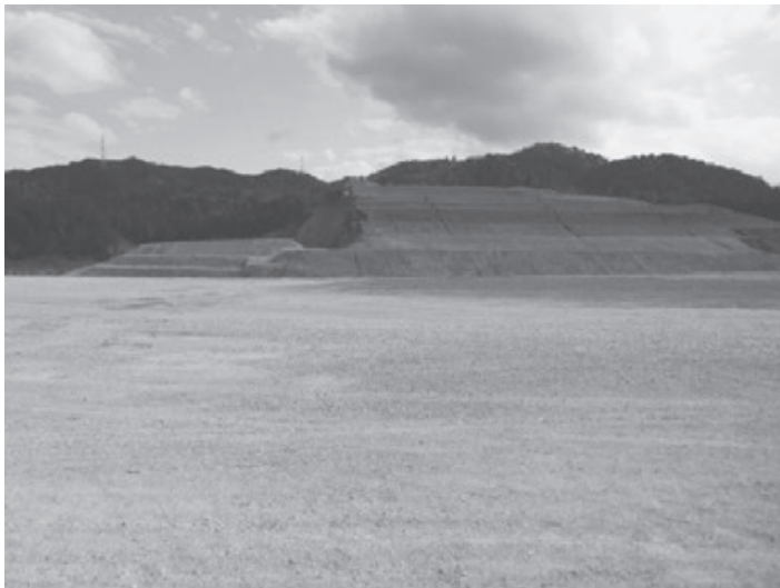
新庁舎建設予定地
