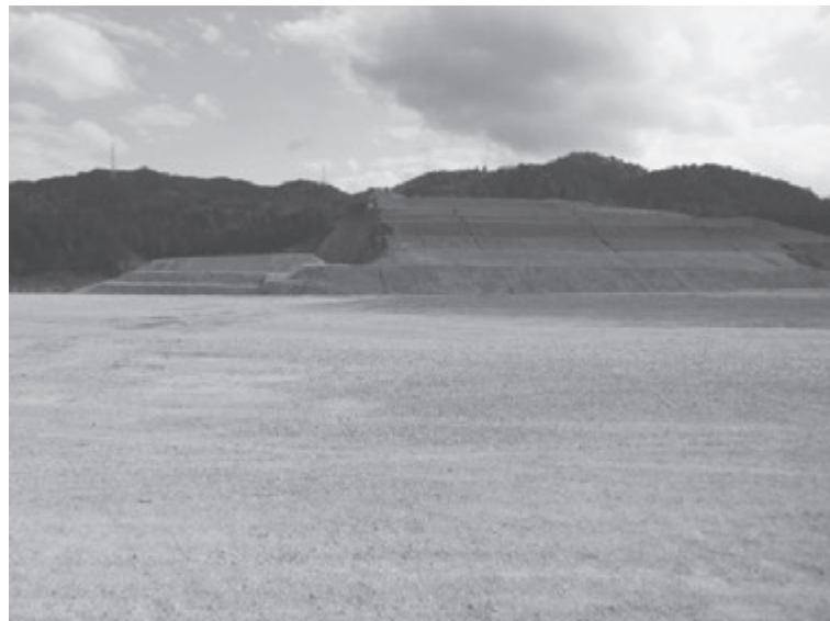
新庁舎建設予定地
