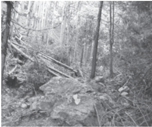
倒木・流木が土石流の原因にも
