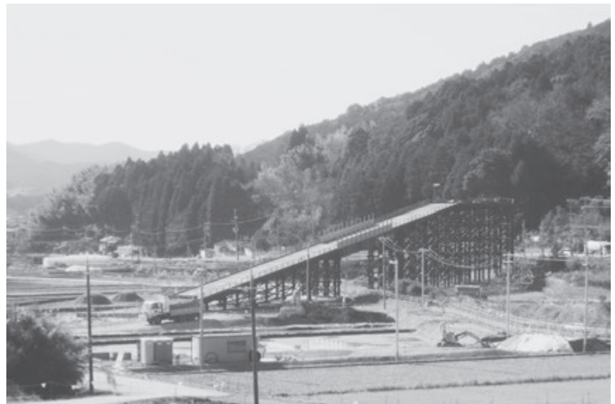
新名神工事現場(岩山)
