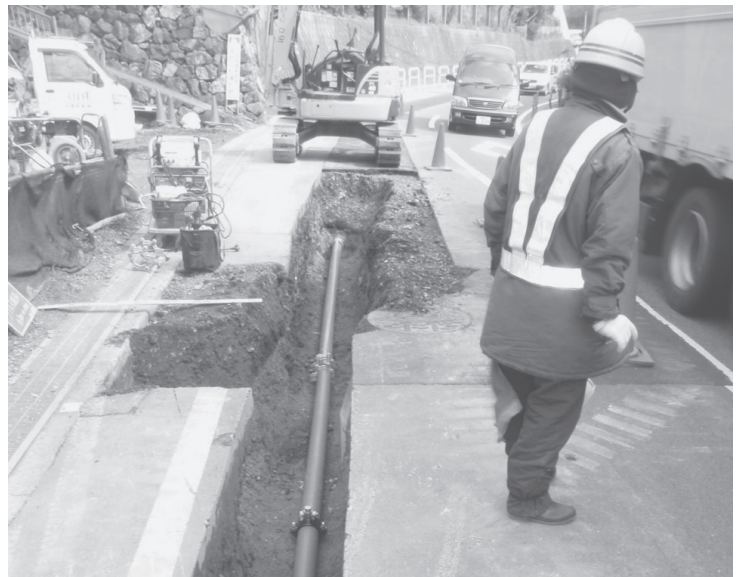
水道管の敷設替え工事
