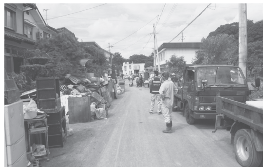
豪雨災害による復旧作業（福知山市）
