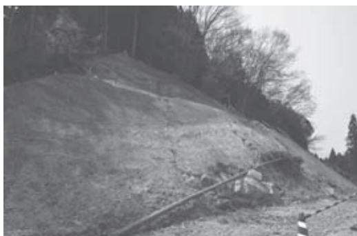
災害復旧現場 (湯屋谷)
