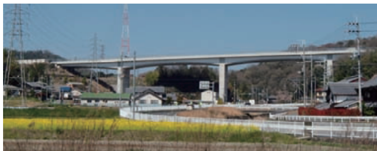
新名神高速道路 草津田上～信楽間（宇治田原第二高架橋と同形式）
