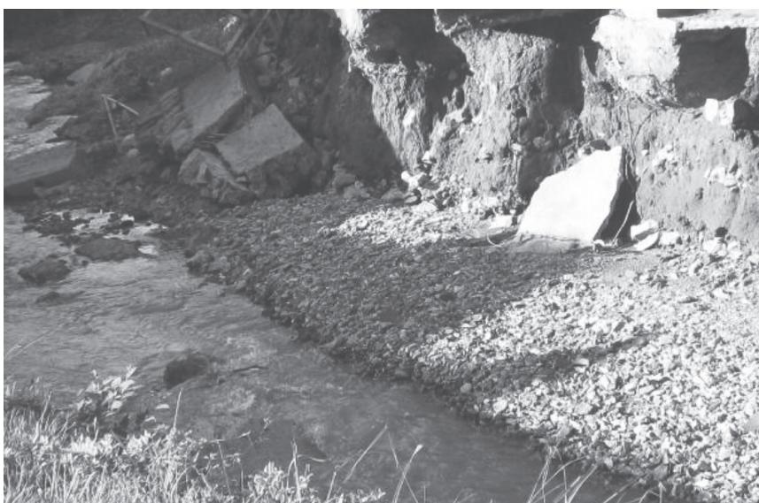
護岸が損壊した河川
