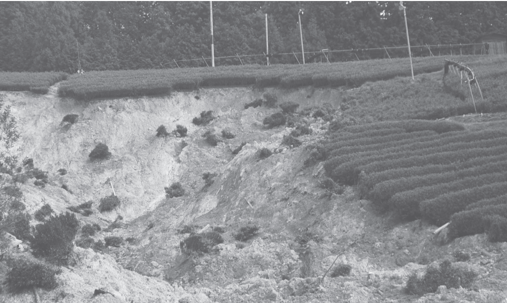
台風 18 号の豪雨で崩れた茶園 (禅定寺時雨谷)
