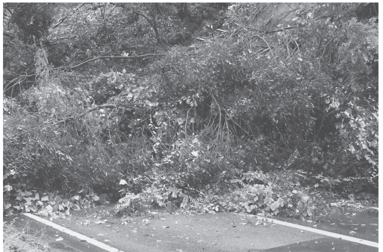
土砂崩れで通行止めとなった国道307号(岩山)9月16日未明
