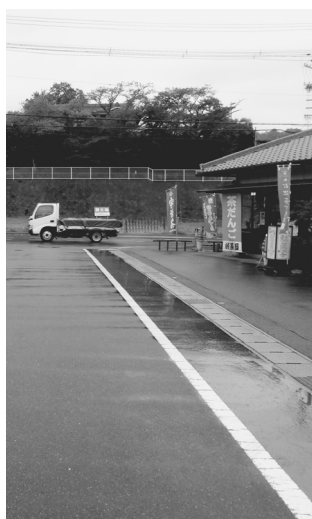
カラー舗装された町道
