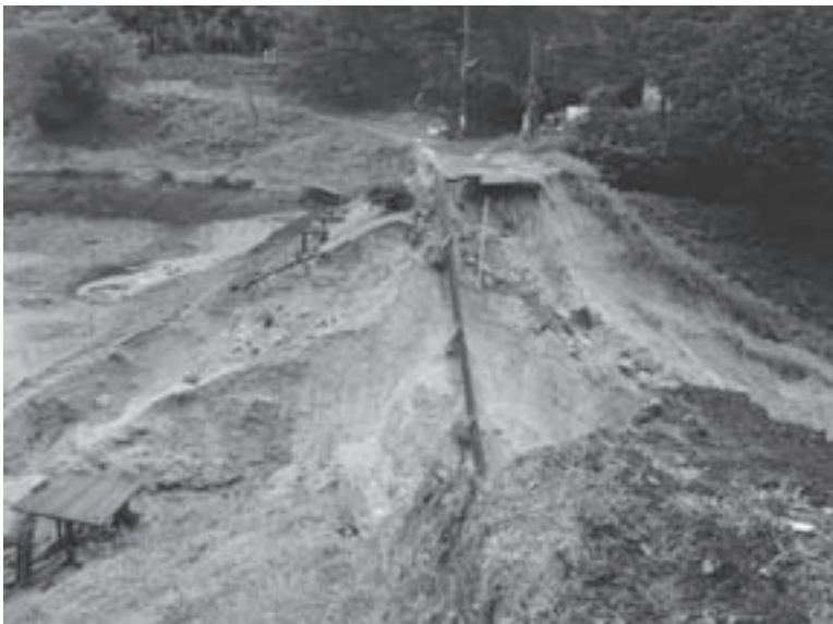
決壊したくつわ池
