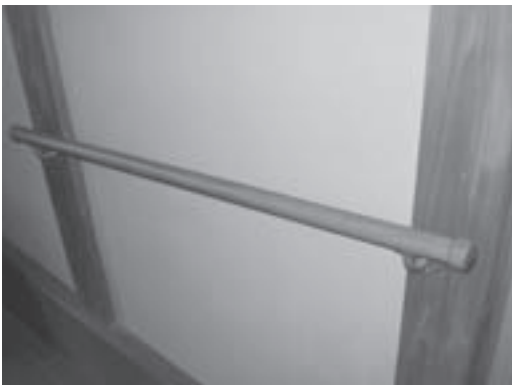
手すりをつけて転倒防止
