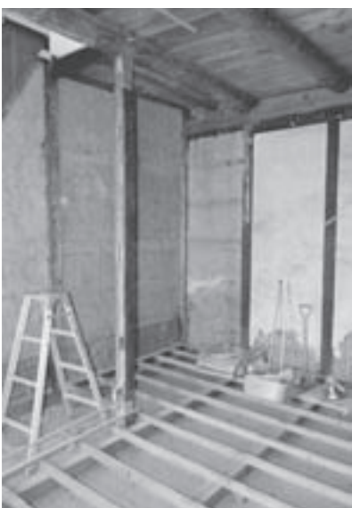
耐震補強工事
