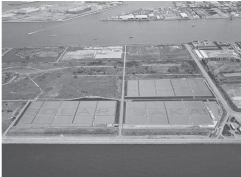
メガソーラー発電施設 (堺市) (写真：関西電力提供)
