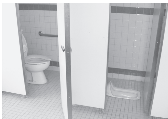
小学校トイレ
