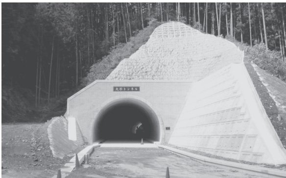
大杉トンネル
