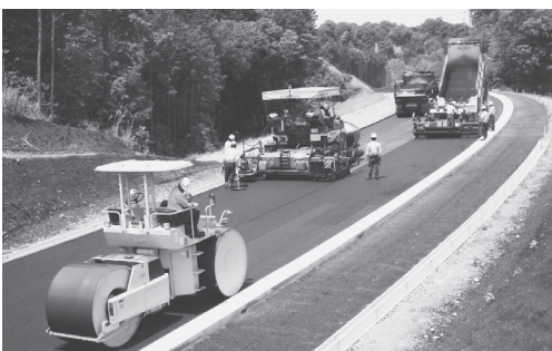
工事が進む南バイパス
