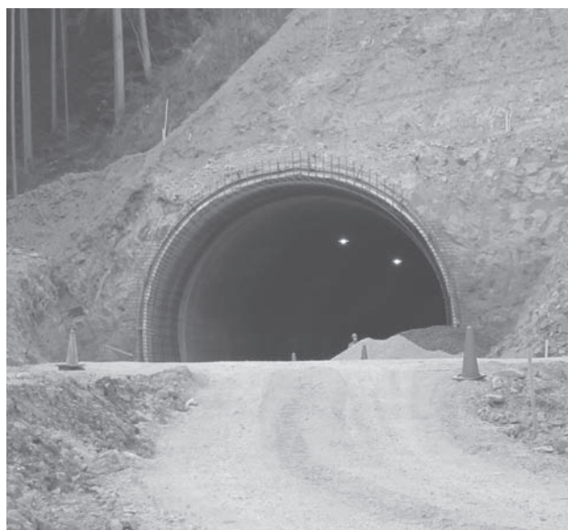
大杉トンネル
