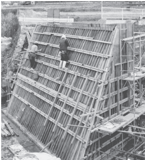
育英橋 (工事中)
