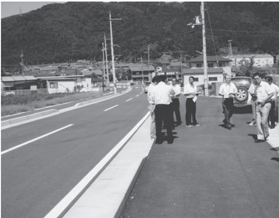
完成したアクセス道路
