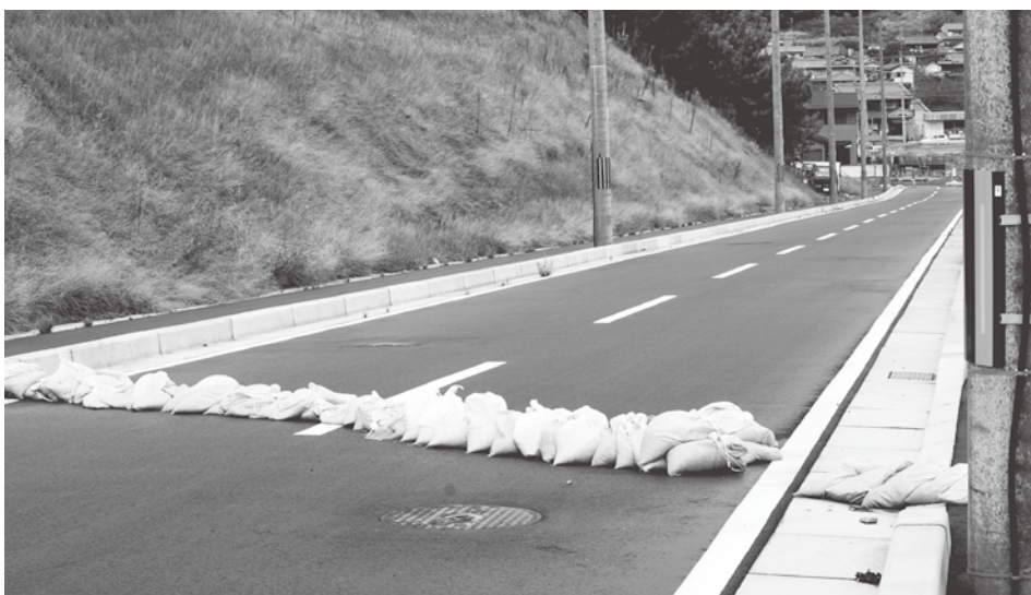
土のうがおかれた新都市アクセス道路
