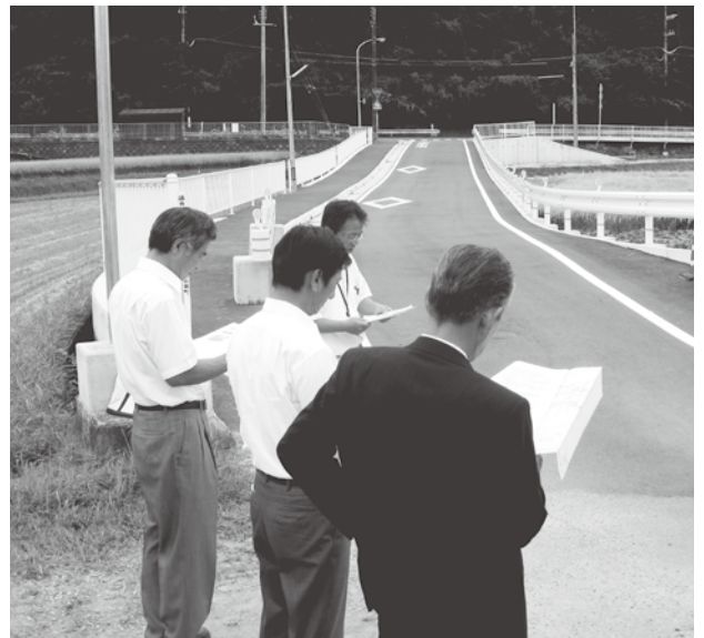
育英橋～R 307号通学路拡幅工事
