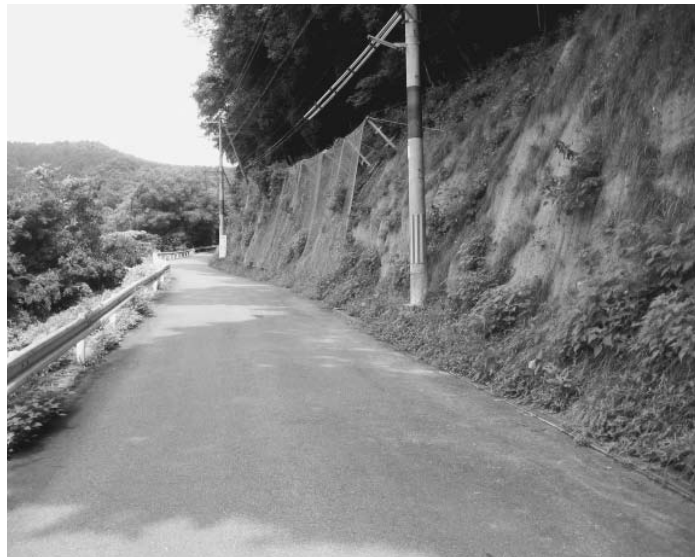
修復された町道郷之口高尾線
