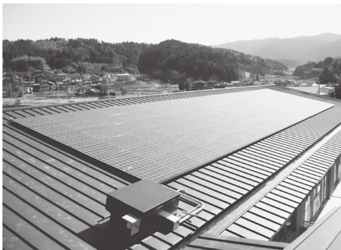
維孝館中学校の太陽光パネル
