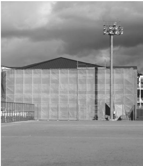
改修中の維孝館中学校体育館
