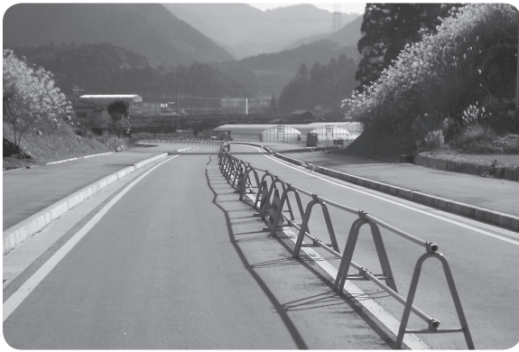
工事が進む南バイパス
