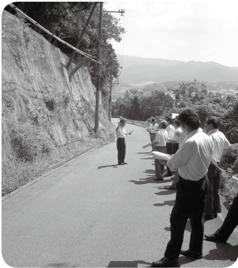
高尾地区緊急防災対策事業 (郷之口高尾線)
