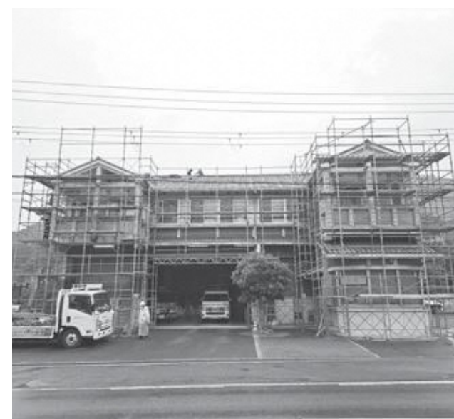
京田辺市消防署宇治田原分署改修工事
