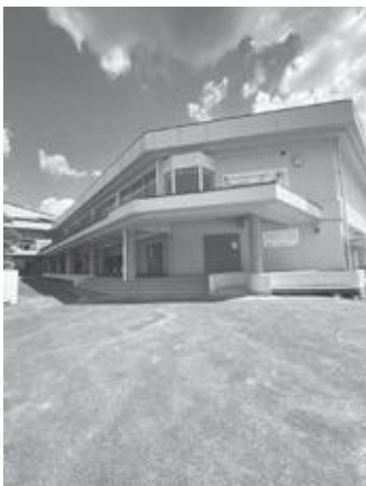
維孝館中学校体育館
