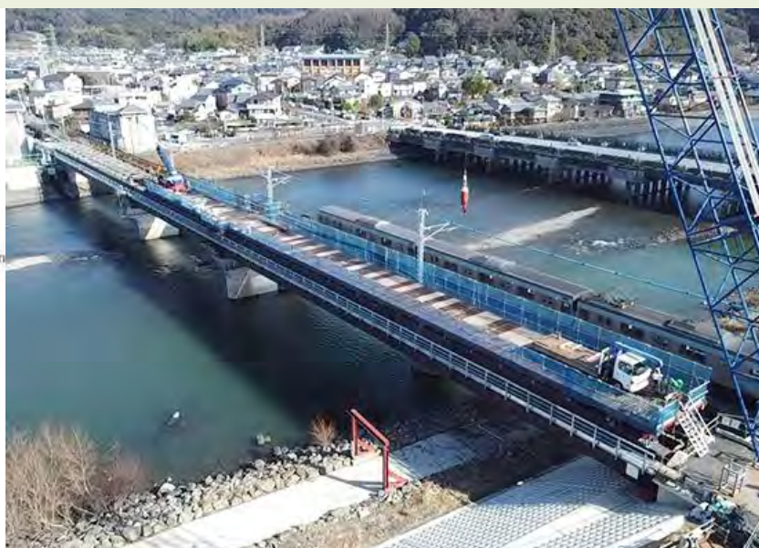
出典：JR 西日本 写真 黄檗～宇治間の工事状況(宇治川橋梁)
