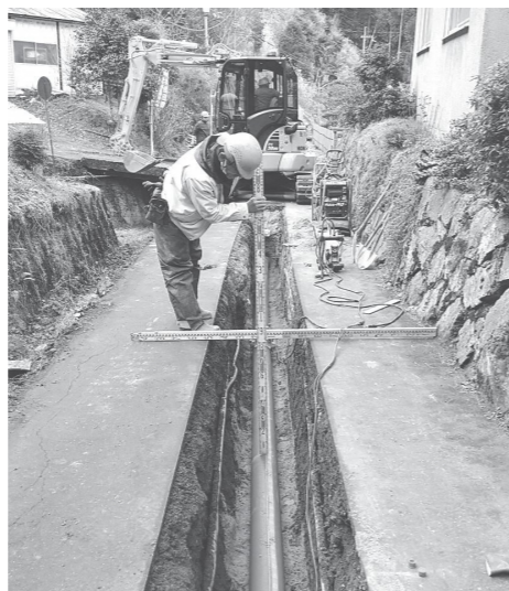
配水管布設工事
