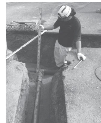
耐震水道管工事
