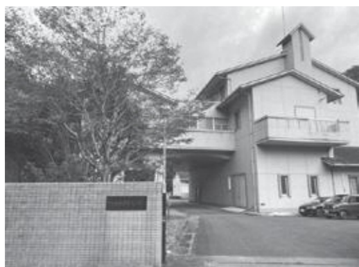
浄化センター
