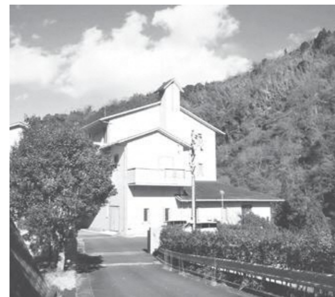
浄化センター
