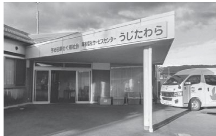
障害福祉サービスセンターうじたわら
