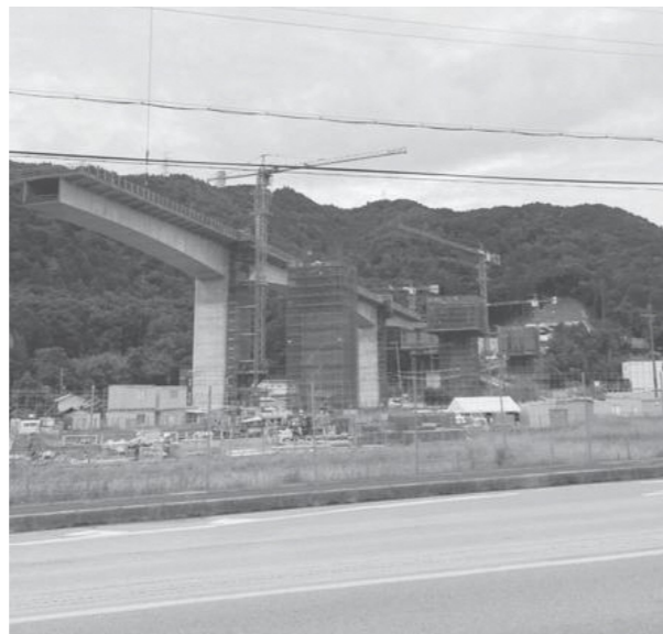
新名神高速道路工事
