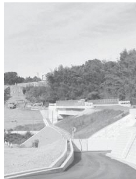
山手線延伸工事 南バイパスから役場方面
