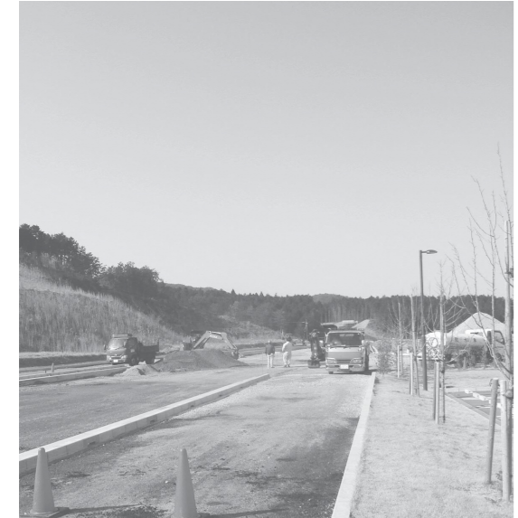
山手線整備状況 (庁舎～南区間)
