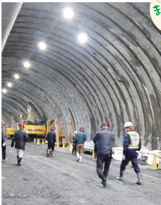
新名神トンネル西工事・現場見学会（郷之口）
